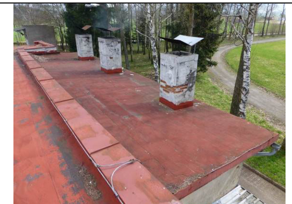
Přezdění komínů nad kovárnou
